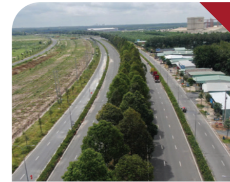
XÂY DỰNG HẠ TẦNG
